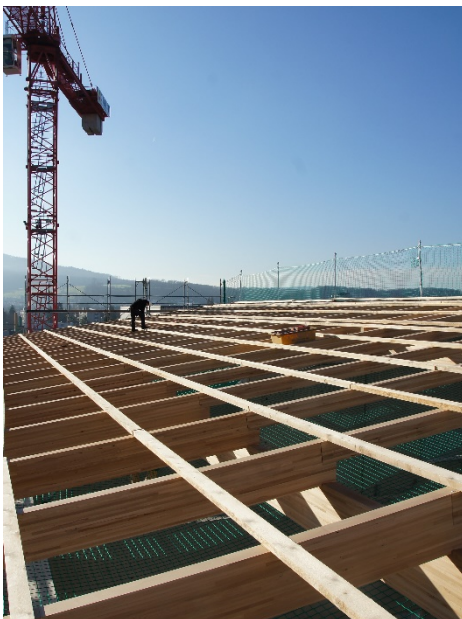
Une charpente en lamellé-collé de hêtre suisse. Ici les longues portées du toit du bâtiment de la centrale thermique du groupe Raurica à Muttenz (BL). (Photo: Andres Klein)
